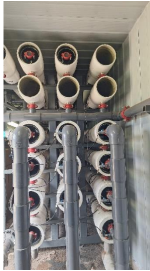
Figura 5. Rack de membranas de 8" x 60". Fuente: Confidencial.
