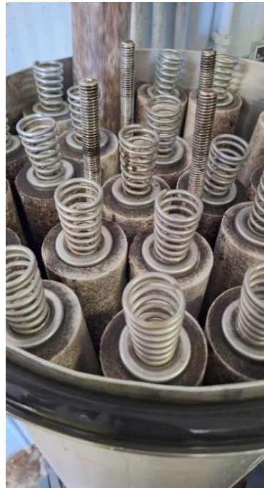
Figura 13. Inspección del operador en cambio de cartuchos por funcionamiento de 336 hrs (14 días). Fuente: Confidencial.
