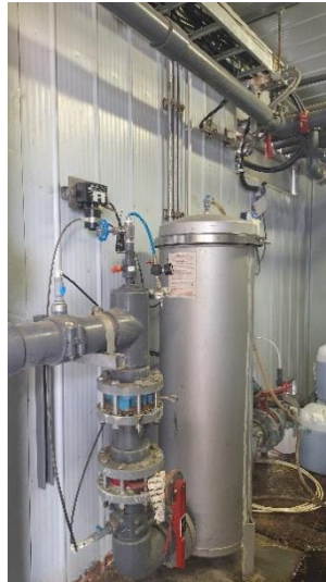
Figura 6. Porta cartuchos de subsistema de prefiltros length 40 [in], Micron 5 [um]. Fuente: Confidencial.
